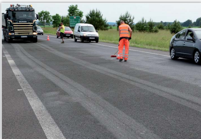
Stabilizacja nawierzchni posypką kamienną
