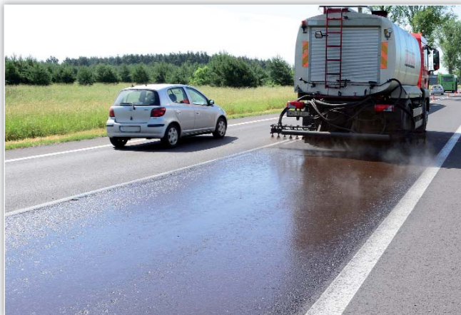
Skropienie penetrującym lepiszczem
