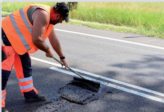
Miejscowy remont nawierzchni zaprawą emulsyjno-mineralną
