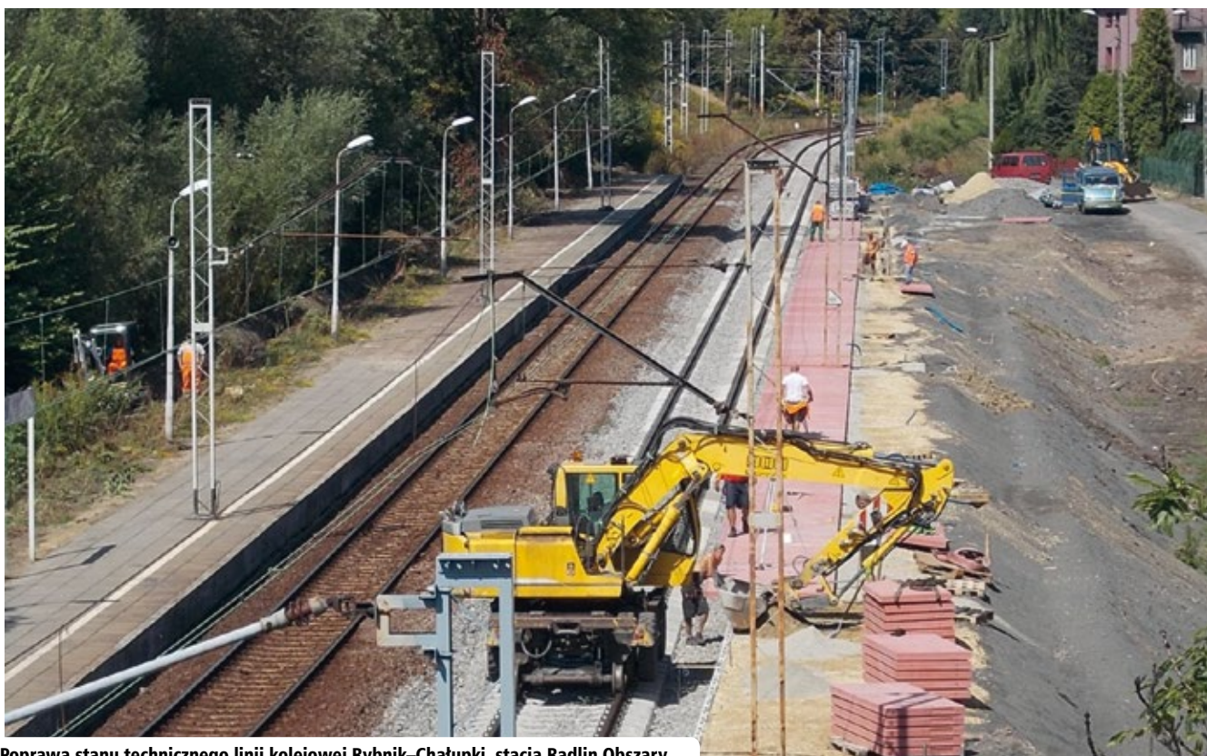
Poprawa stanu technicznego linii kolejowej Rybnik–Chwałupki, stacja Radlin Obszary
