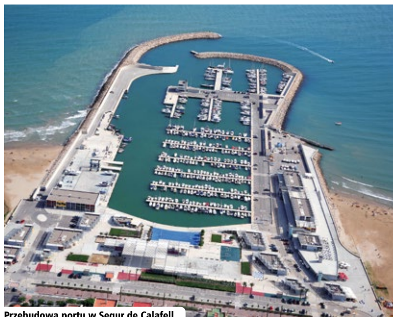
Przebudowa portu w Segur de Calafell
