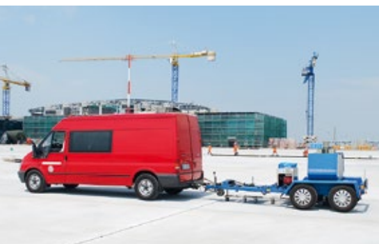
Pomiar ugięć sprężystych nowo wybudowanej nawierzchni lotniskowej z betonu cementowego za pomocą ugięciomierza lotniskowego HWD
