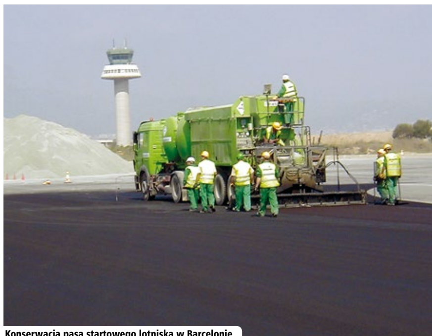
Konserwacja pasa startowego lotniska w Barcelonie
