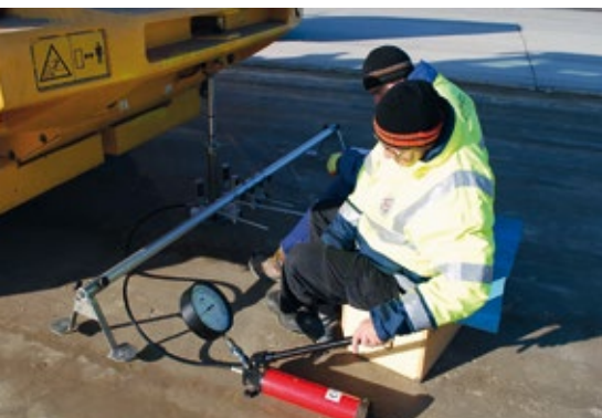
Badanie sprawdzające parametr nośności warstwy podbudowy pomocniczej wykonywane aparaturą VSS
