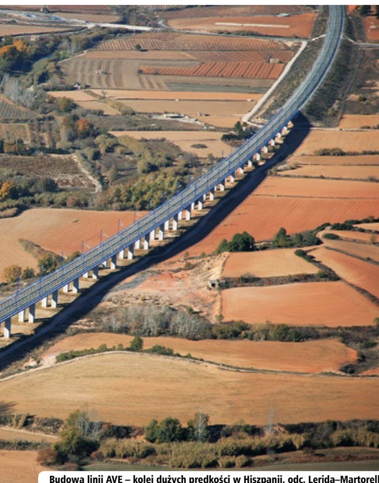
Budowa linii AVE – kolei dużych prędkości w Hiszpanii, odc. Lerida–Martorell
