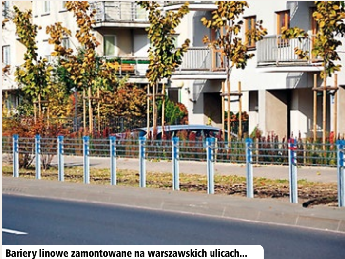
Bariery linowe zamontowane na warszawskich ulicach...
